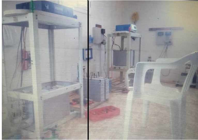
شكل (2) جهاز التحكم الهايبرد / الهجين : منظم شحن / انفرتر 1500 وات
