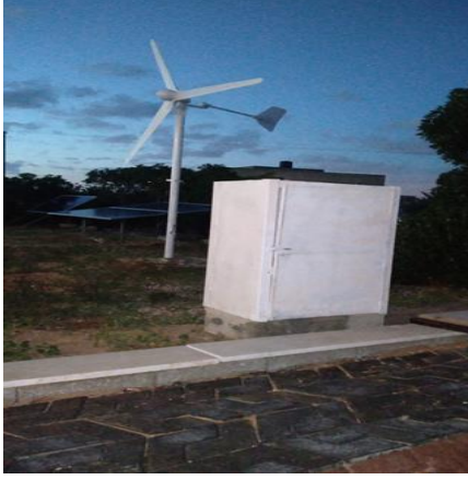
شكل (1) منظومة الهايبرد / هجين 1300 وات : 1000 وات رياح / 300 وات شمس
