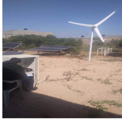
شكل (1) منظومة الهايبرد / هجين 1300 وات : 1000 وات رياح / 300 وات شمس
